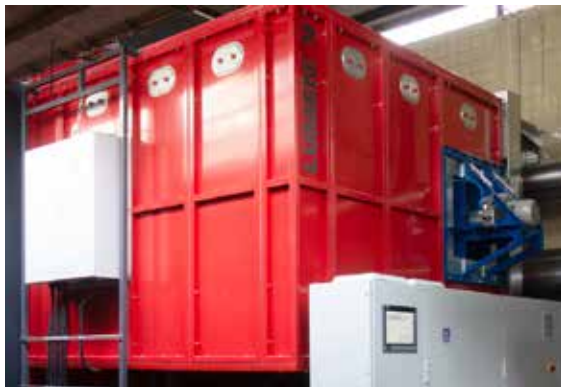
Stahlspeicher von LUMENION im Heizhaus eines Berliner Wohnquartiers
